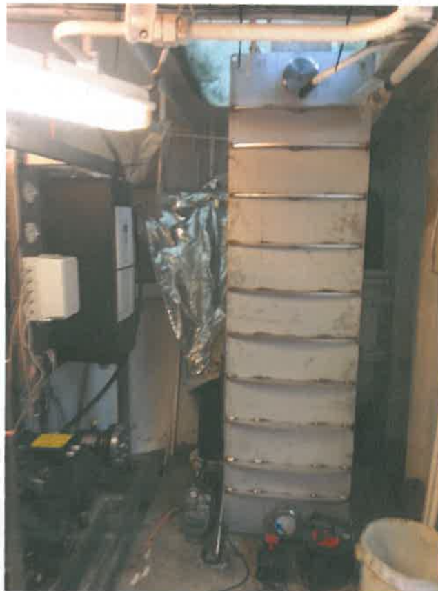
Bilde 2. Kondensator under montering i båt
